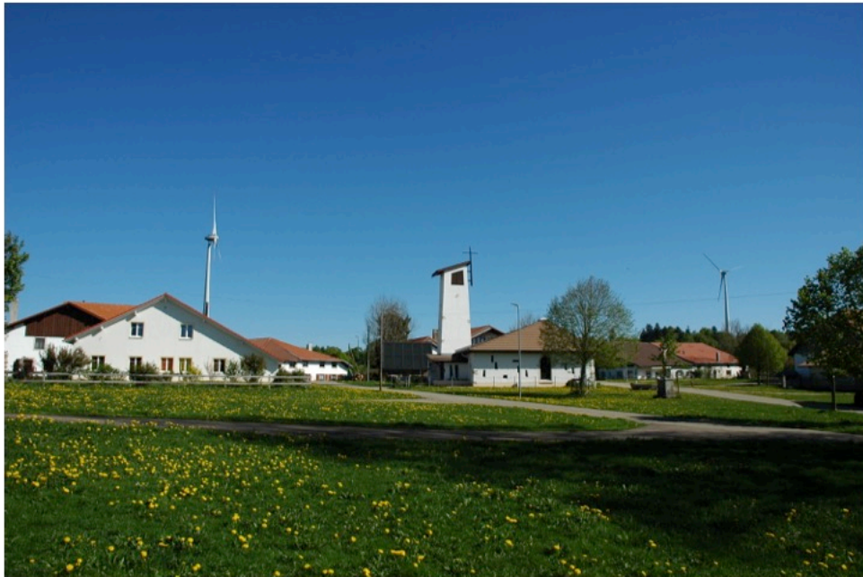
Abb. 13 Zwei der drei Anlagen des Windparks Le Peuchapatte hinter der Siedlung Le Peuchapatte in der Gemeinde Muriaux (eigene Darstellung 2018)
