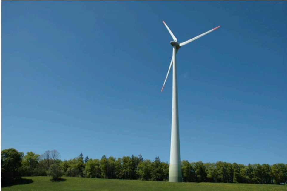
Abb. 15 Die drei Anlagen des Typs E-82 E2 des Windparks Le Peuchapatte messen eine Nabenhöhe von 108m (eigene Darstellung 2018)
